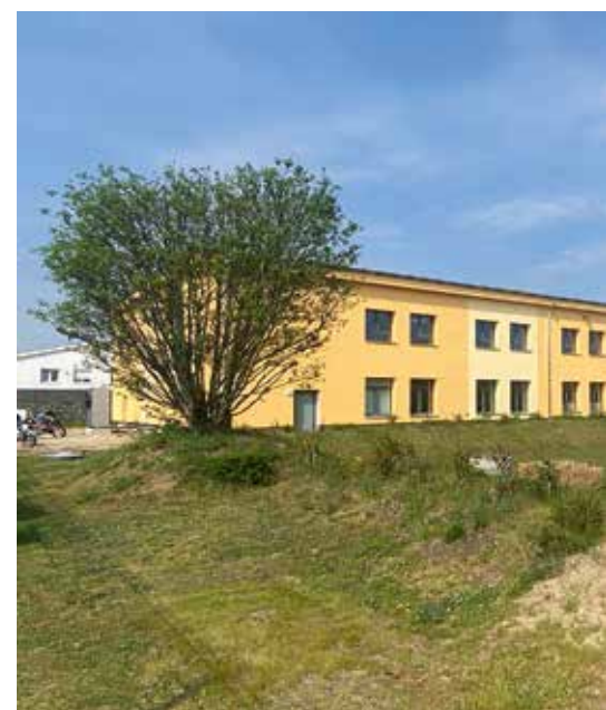
Haus 27 u. Regenwasserversickerungs
