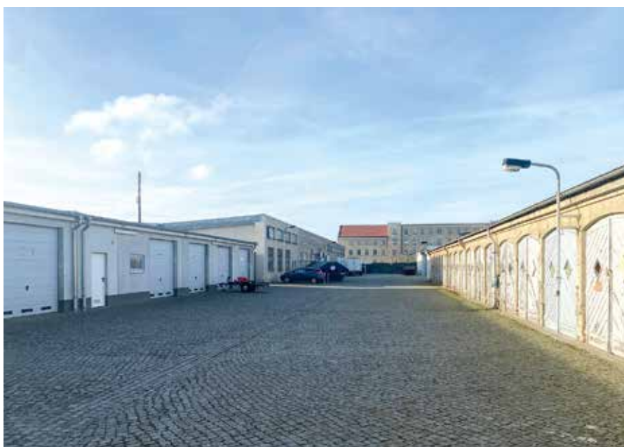
Wackenbergstr. 95: Neue und alte Garagen auf dem Gewerbehof
