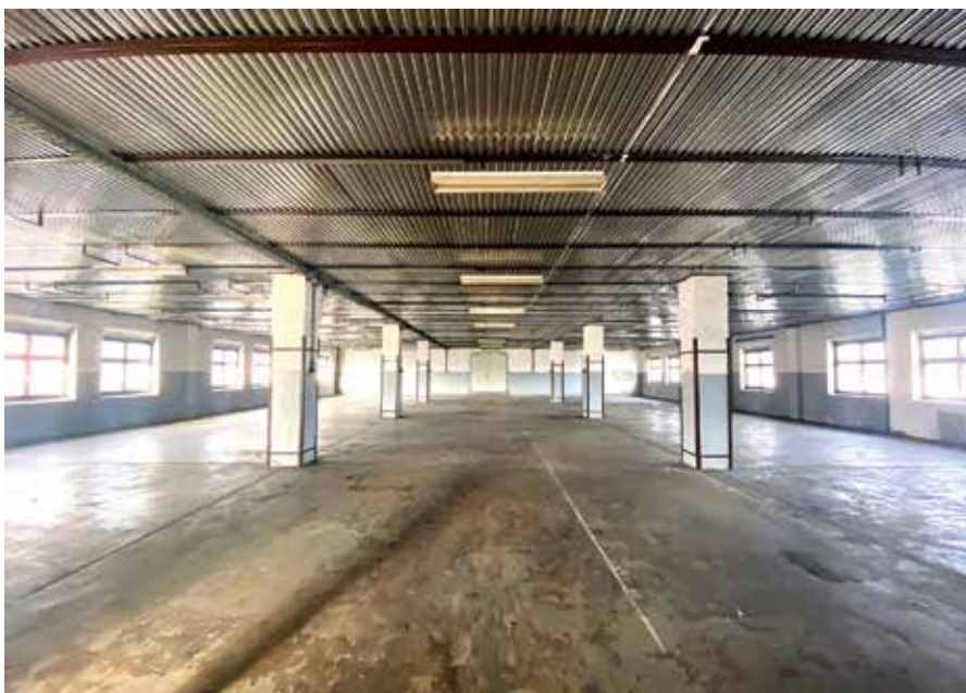
Haus 25: 1. Obergeschoss vor Baubeginn
