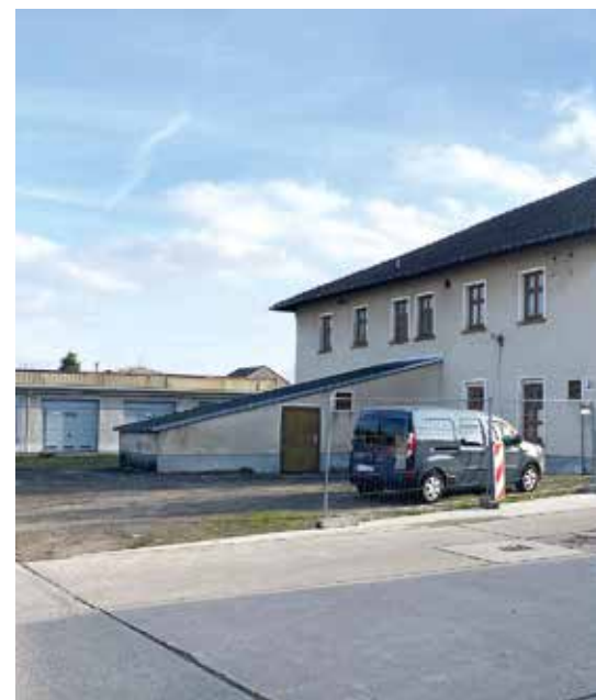
Haus 25: Außenansicht Nord-West vor
