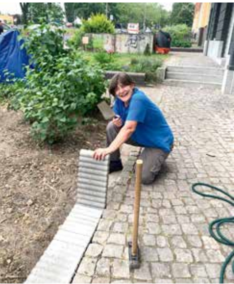
Kantensteine zu verlegen, ist schwer und will gelernt sein.
